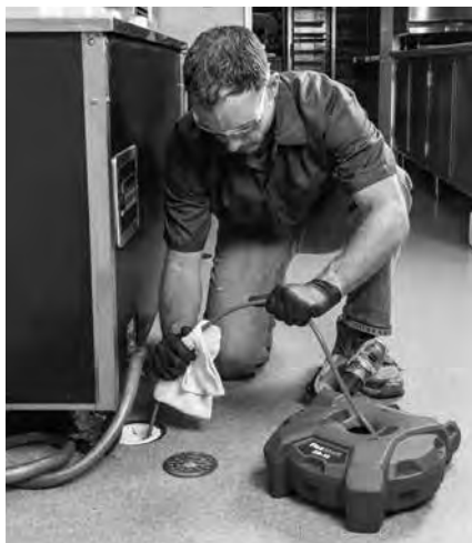
Obrázok 15 – Nanášanie maziva na plášť kábla
